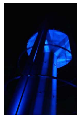
Château d'Eau à Steinfort
